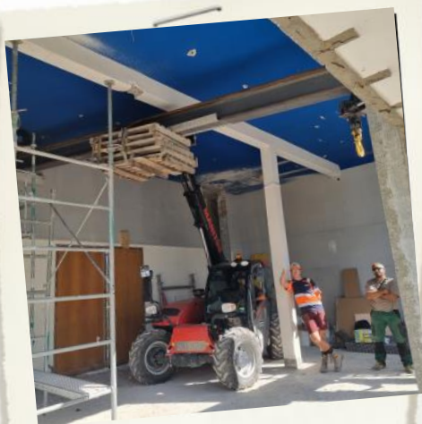
Pose de la poutre centrale de la pièce + visite d'Emmanuel Faber
