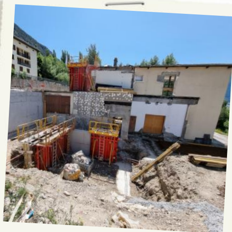
Démarrage de la construction
